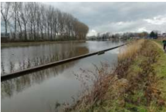
Voorbeeld van een voorgeplaatste damwand.
